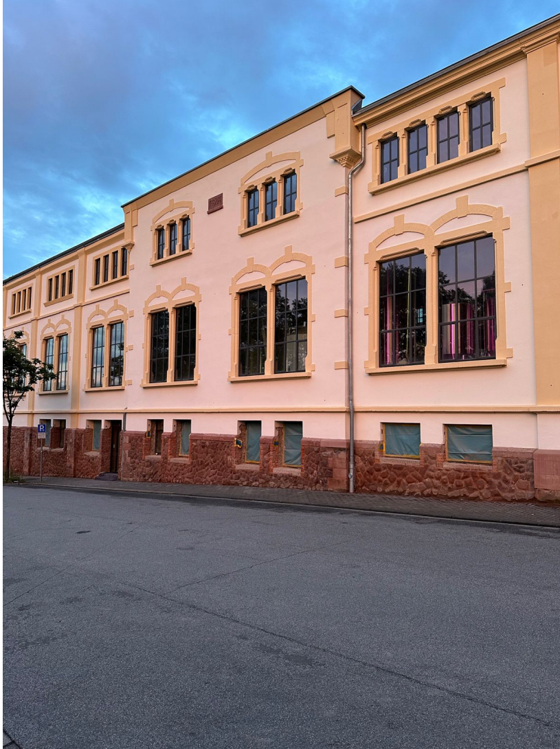
Bruch Brauerei, Saarbrücker Straße, Neunkirchen (Quelle: Bruch Brauerei)
